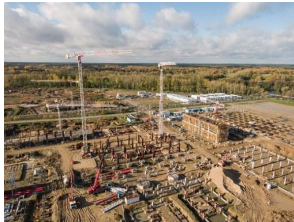
Plac budowy instalacji polipropylenu
