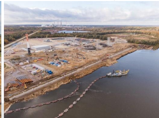
Widok na plac budowy terminalu przetadunkowo-magazynowego
