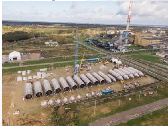
Prefabrykacja silosów magazynowych na polipropylen
